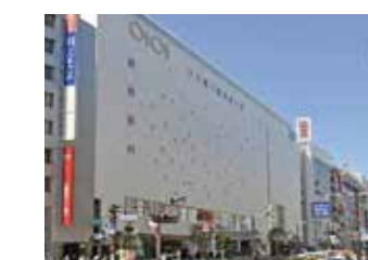
● 再生可能エネルギー導入 (新宿マルイ本館 ほか)
